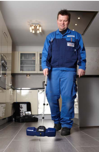
Fig. 32: Localizzazione della testata VIS nel pavimento
