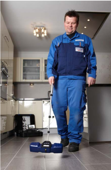
Afb. 25: Lokalisatie van de camerakop in de vloer
