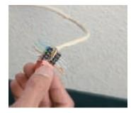
2. Determine wiring scheme. Dress all 4 pairs (8 wires).
