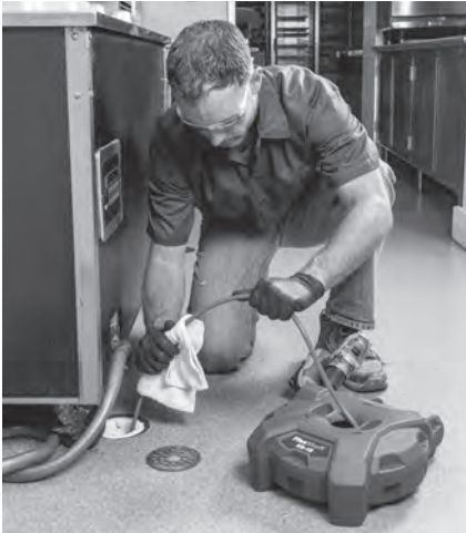
Figure 15 – Application de lubrifiant sur la gaine du câble
