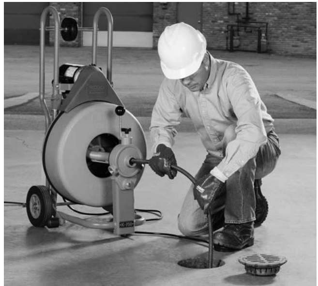
Figura 12 – En la posición correcta para trabajar, el operario alimenta manualmente el cable en el desagüe
