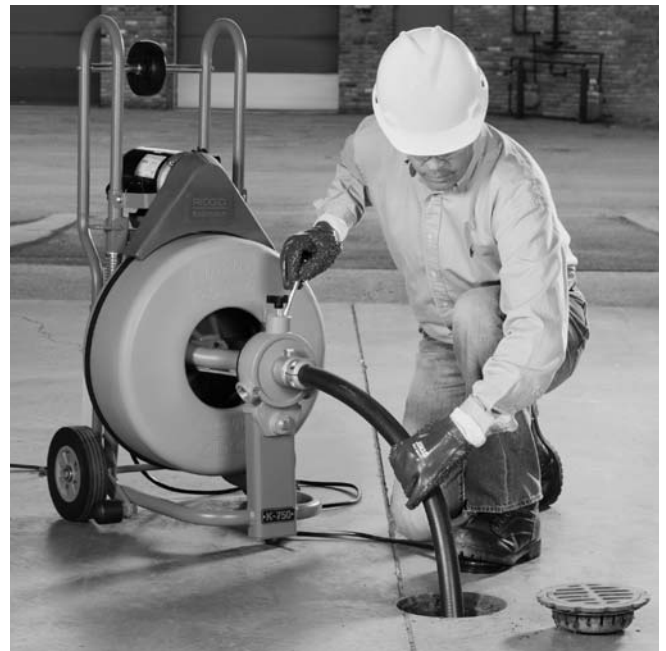
Figura 15 – Empleo de una limpiadora con manguera-guía delantera
