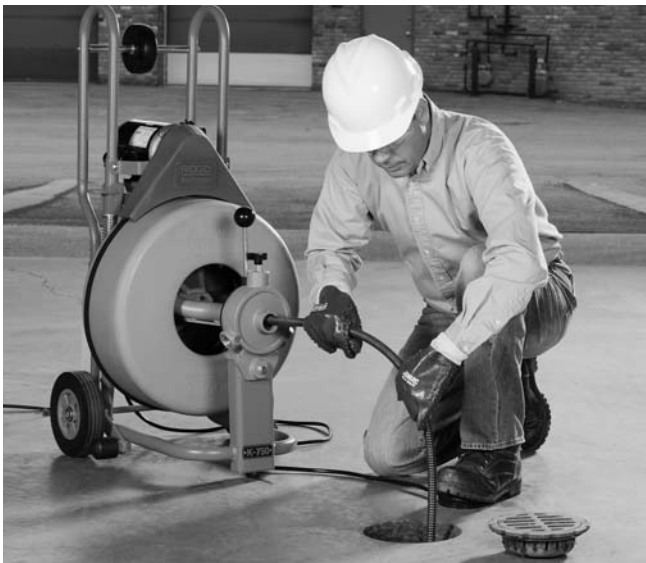
Figure 12 – Avancement manuel du câble en position de travail
